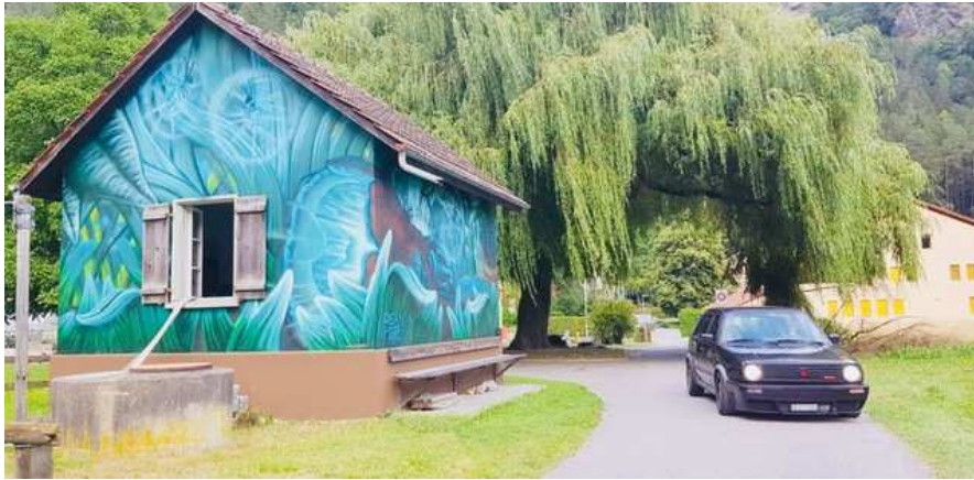
Pumpenhäuschen in Rothenbrunnen
